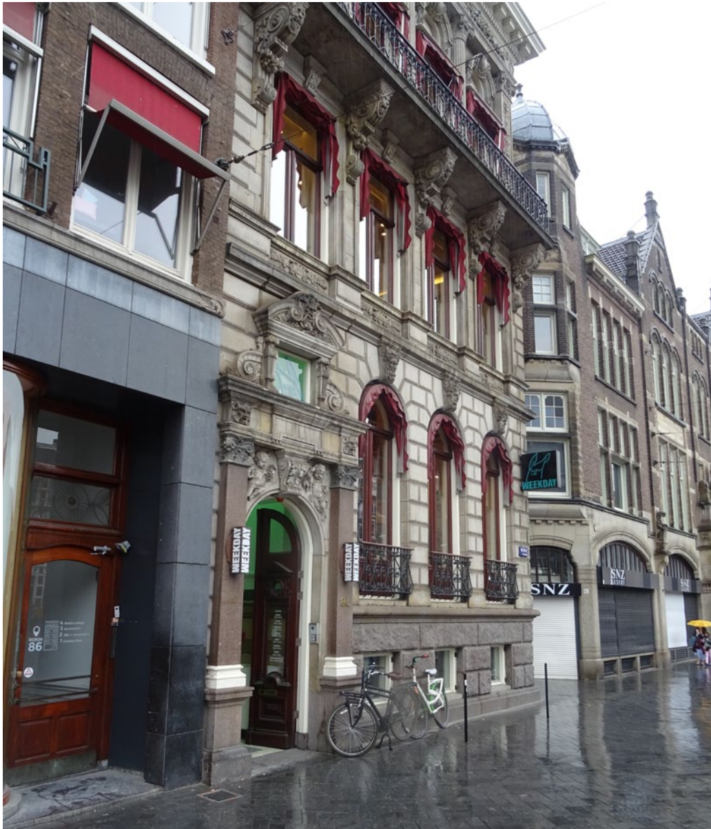
◀ Abb. 11. Ehemaliges Restaurant Riche, Rokin 84, Amsterdam (1882), eines der frühen Werke in den Niederlanden mit Granit von KESSEL & RÖHL.
