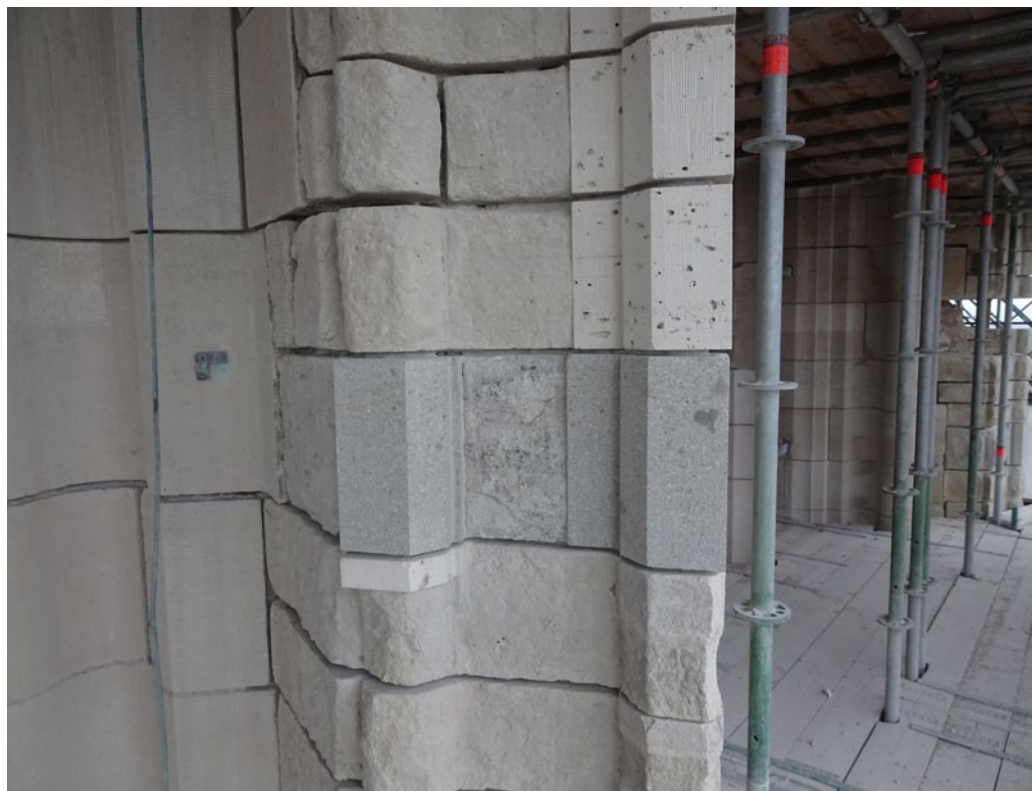
► Abb. 14. Montemerlo-Trachyt aus den Colli Euganei in Venetien, der als Ersatz für den Drachenfels-Trachyt seit 2003 am Kölner und Xantener Dom verwendet wird.
